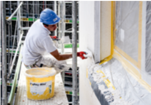
Das Material wird aufgezogen und dann mit Wasser und Schwamm ein Teil der Materialstärke wieder abgetragen.
