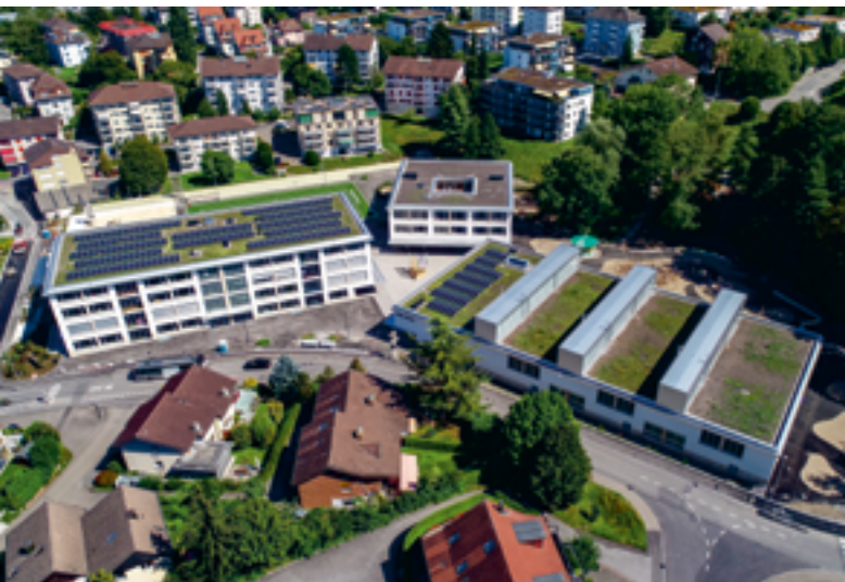
Zur grössten Luzerner Schulanlage gehören drei Gebäude, welche ein starkes Ensemble bilden.
