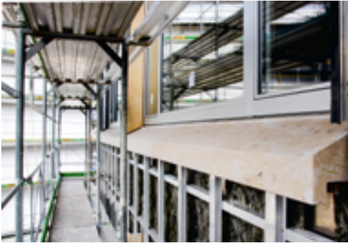
Fensterbänke, Lisenen und Sockelverkleidungen aus Laufener Kalkstein und die Sockelabschlüsse an der Fassade aus Gubersteinen unterstreichen die Natürlichkeit der Fassade zusätzlich.
